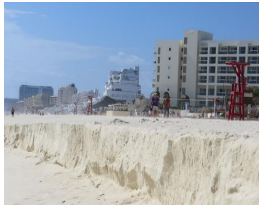
Foto 2. Socavación de cimentaciones de hoteles, deslave de playas enteras.
