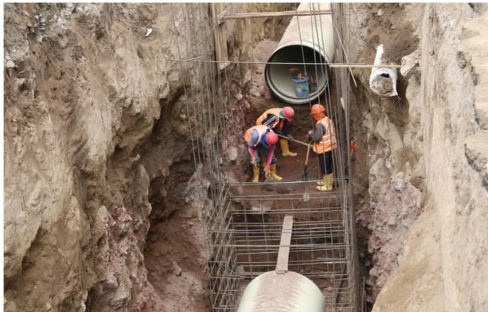
Figura 3. Contaminación del río Chibunga, trabajo de ingeniería para trasladar aguas servidas sin tratamiento directamente al río Chibunga. Fotografía Diario La Prensa.
